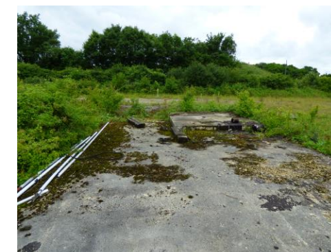
Photo 30 : Dalle de béton, déchets de démolition de bâtiments et bitume
