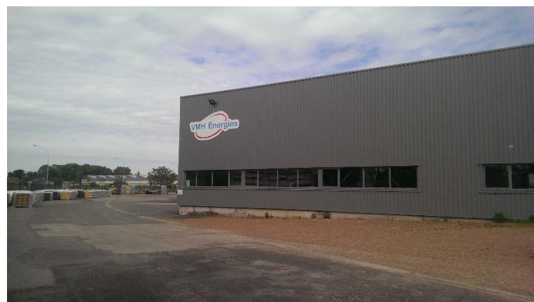
Photo 31 : Vue de l'unité d'assemblage de VMH Energie à Châtelleraut (86)
