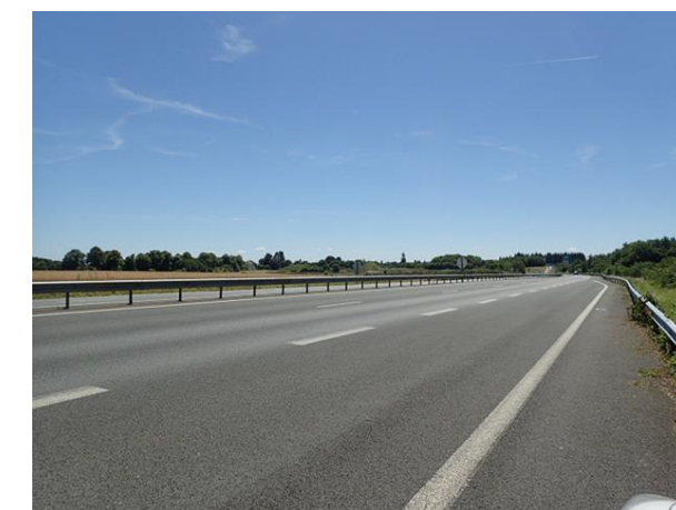
Photo 20 : site du projet depuis la RN10
