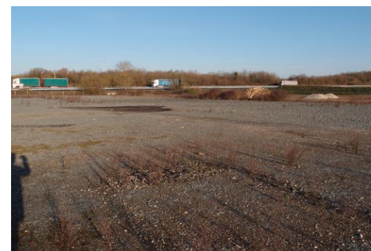
Photo 27 : Ancienne plateforme de stockage de matériaux de construction
