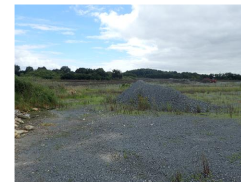
Photo 28 : Matériaux de construction
