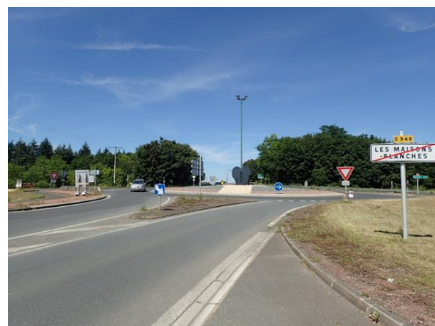
Photo 18 : giratoire des Maisons Blanches
